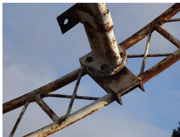
Obr. 6 a, b Otočné spojení příčníku a vnitřního kruhového nosníku
