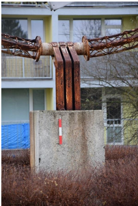
Obr. 4 a, b Betonový podstavec a základový svařenec
