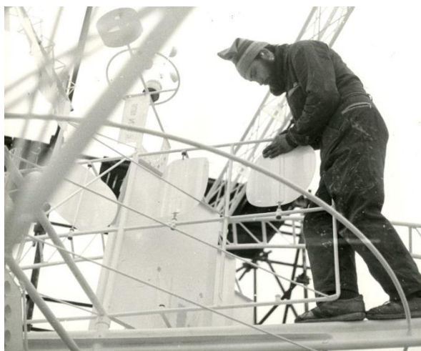
Montáž drobných dílů do horní části vestavby
