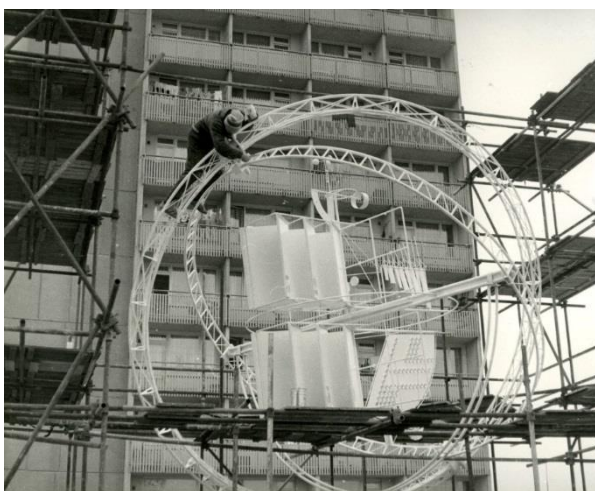
Úpravy na ložisku mezi vnitřním a vnějším ocelovým kruhem
