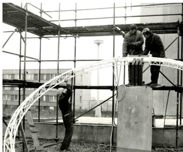
Vnější kruhový nosník před vztyčením
