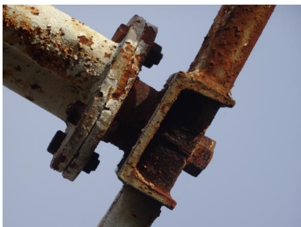
Obr. 6 a, b Otočné spojení příčníku a vnitřního kruhového nosníku
