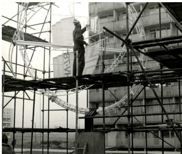
Montáž vestavby do vztyčené ocelové konstrukce
