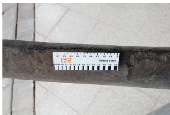
Obr. 7: Prasklina ve vrchní vrstvě laminátu
