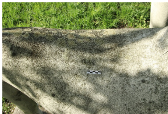
Obr. 14: Silné biologické znečištění povrchu laminátu
