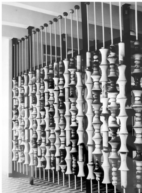
Obr. 5 Keramická stěna šaten ve škole v Chabařovické ulici, 1969–1971. Foto: Archiv Jindřišky Radové
