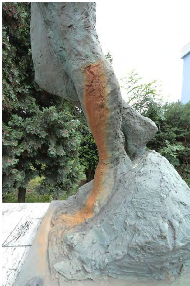
Obr. 6. Vytékání korozních produktů ocelové výztuže přes prasklinu v noze sochy Fig. 6. Outflow of corrosion products of steel reinforcement through a crack in the sculpture leg
