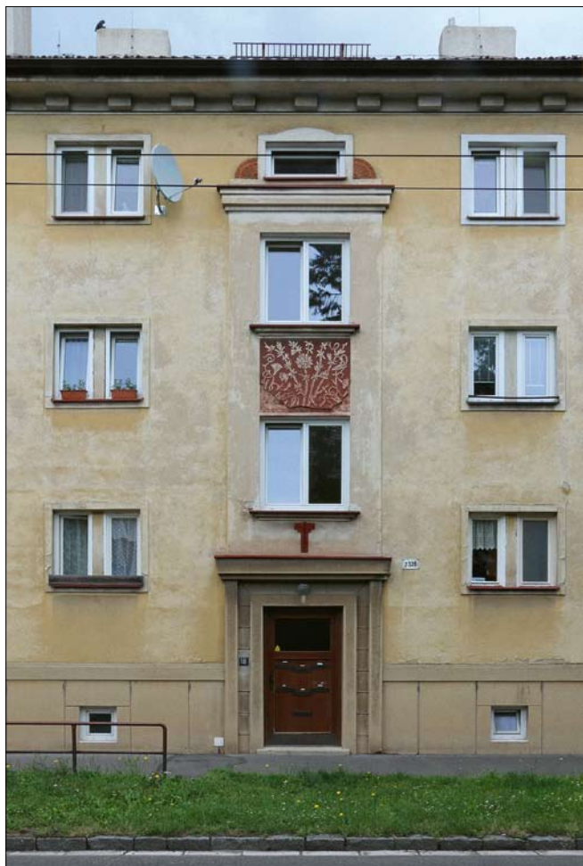
Obr. 20: Pardubice, sídliště Dukla. Fasáda obytného domu z 50. let 20. století s těžce poškozeným sgrafitem. Stav před obnovou fasády (foto L. Machačko, 2017).
