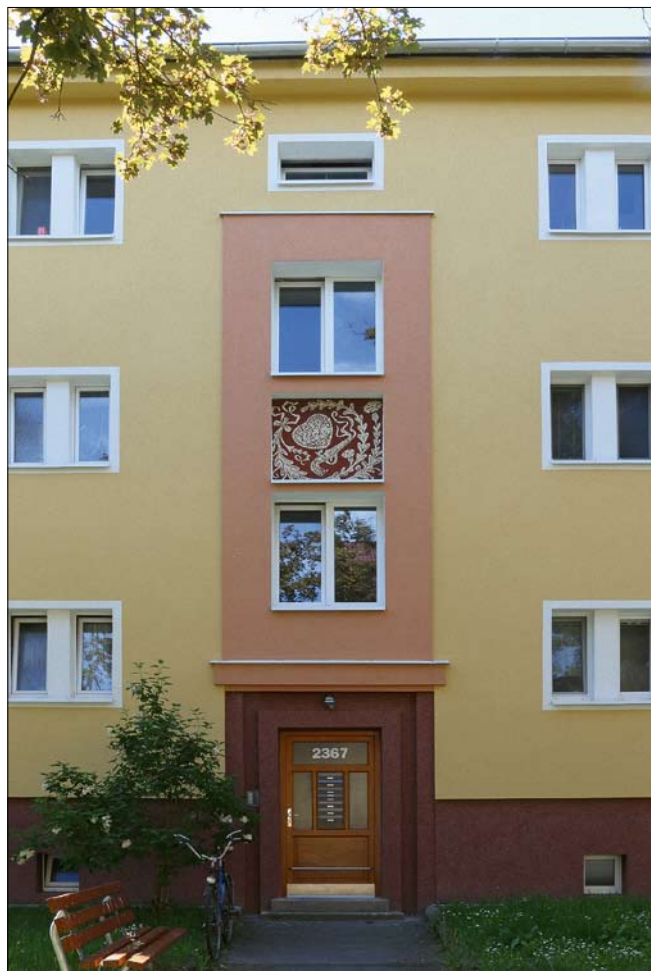
Obr. 21: Pardubice, sídliště Dukla. Fasáda obytného domu z 50. let 20. století po kompletní obnově a zateplení. Sgrafito bylo na fasádě při obnově zachováno a opraveno (foto L. Machačko, 2017).
