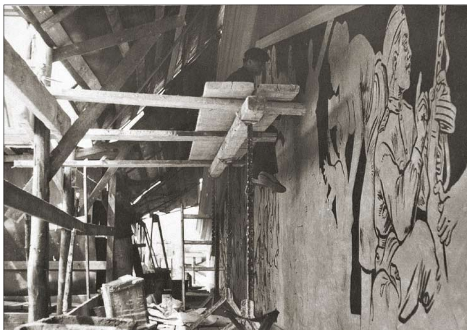
Obr. 8: Pozůstalost Jana Provazníka (v majetku rodiny), J. Provazník na lešení při realizaci sgrafitové kompozice pro ZŠ v ulici Na Nábřeží v Havířově (okres Karviná), asi 1955 (foto J. Ivánek, 2017).
