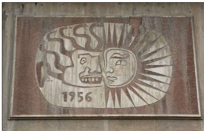
Obr. 25: Brno, Venhudova ulice, sgrafito s motivem Medúzy a Slunce z roku 1956. Stav před restaurováním. Povrch sgrafita silně znečištěn prachem a bělavými vápennými zákaly. V horní části je patrný defekt v omítce (foto L. Machačko, 2017).
