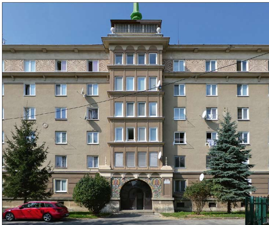
Obr. 1: Nová Dubnica (Slovensko, okres Trenčín), ulice Sady Cyrila a Metoda, průčelí budovy projektované J. Krohou a opatřené na portálu vstupu mozaikou a pod korunní římsou prefabrikovanými sgrafity, 1953–1954 (foto Z. Křenková, 2018).
